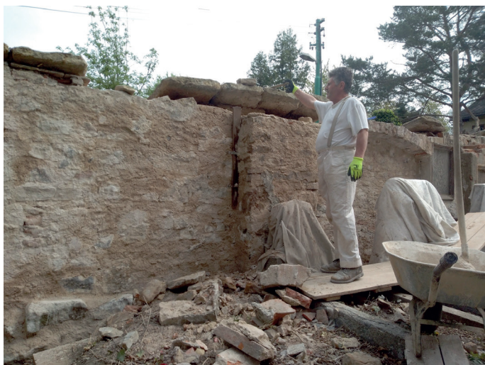
Práce na opravách hřbitovní zdi
